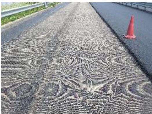
⑥ 그리드 설치 후 모습
