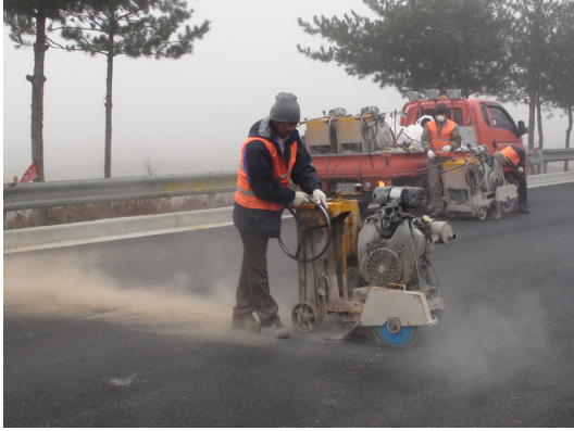
① 균열 부위 절삭
