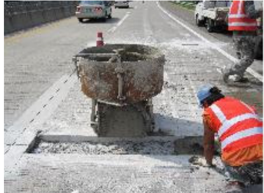
② 콘크리트 채우기
