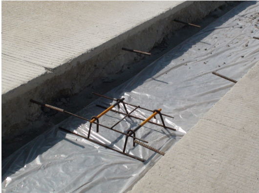
⑦ 다우웰바 설치
