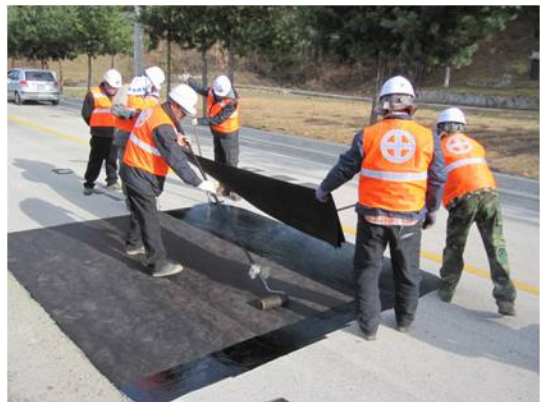
④ 접착제 도포 및 포장섬유 접착
