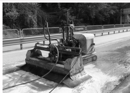
콘크리트 절삭 장비(water-jet)
