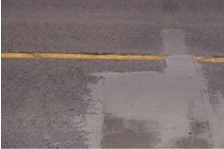
① 기존 콘크리트 보수
