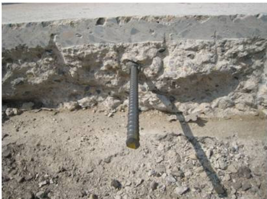
⑤ 타이바 설치
